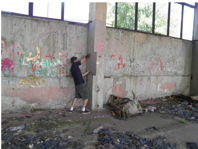
P9120076 носеца армировка в сглобяема колона
