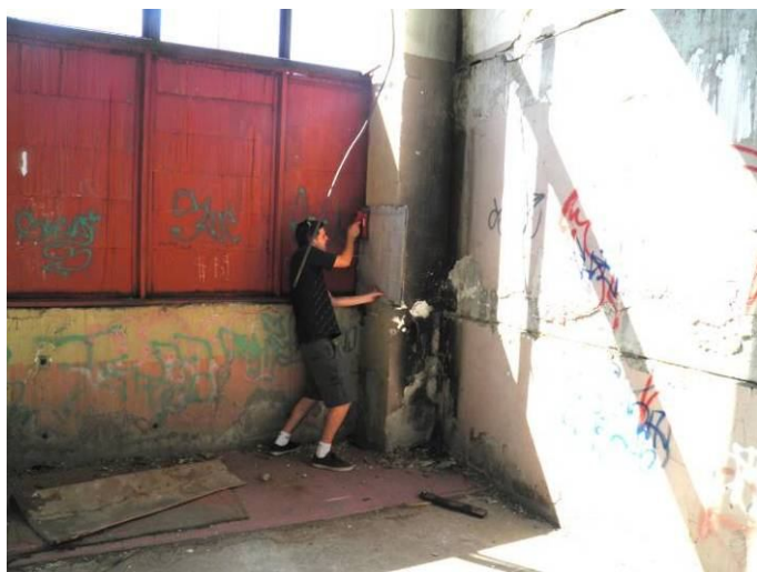
P9120066 носеца армировка в сглобяема колона
